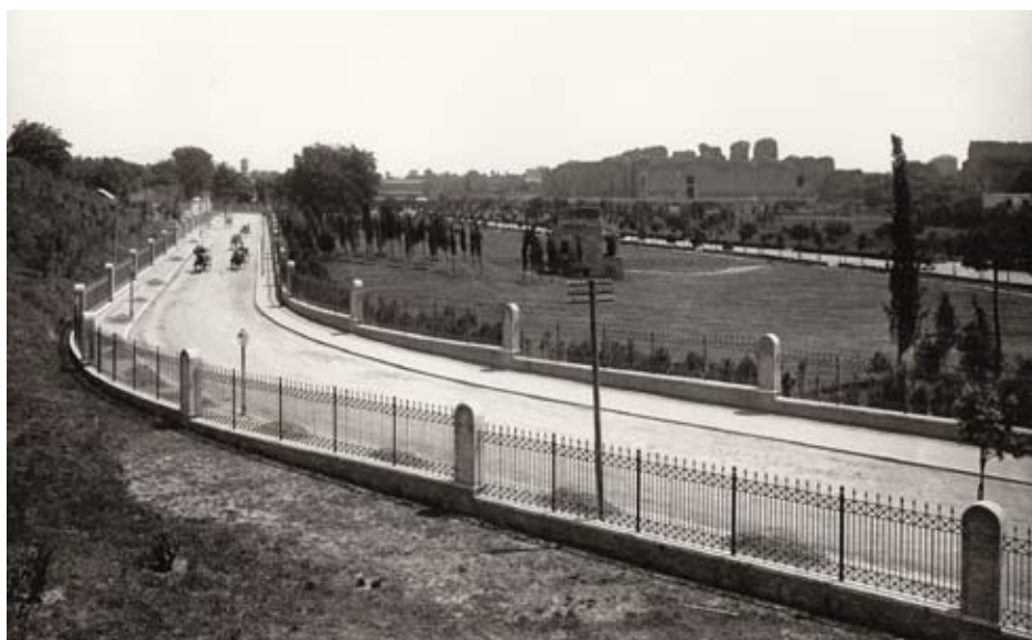
Uno dei nuovi viali corrispondente all'attuale via Valle delle Camene. Nell'aiuola retrostante i resti dell'osteria di Porta Capena isolati dopo le demolizioni. La Zona Monumentale e l'opera della Commissione Reale , Roma, 1914, p. 24, fig. IV:
