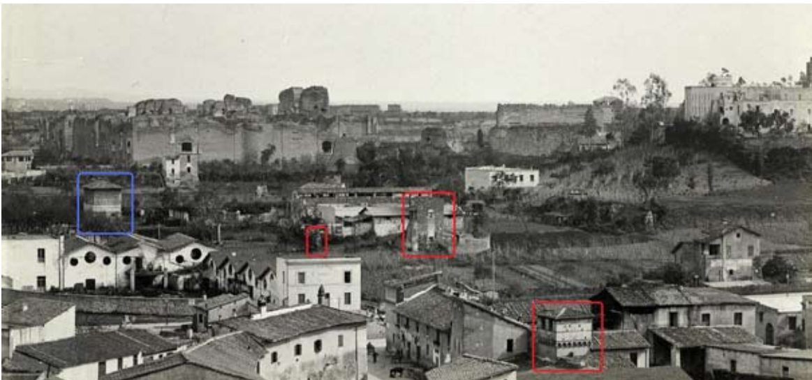
L'area prima delle demolizioni, veduta dal Palatino. In primo piano sulla destra è evidenziata la torre dei Frangipane, dietro la casa-torre denominata "torre del Povero Diavolo" e i resti dell'acquedotto; a sinistra la "Vignola" oggi spostata sul piazzale di Porta Capena. P.P. Mackey, 1901, British School at Rome, Mackey 1237.
